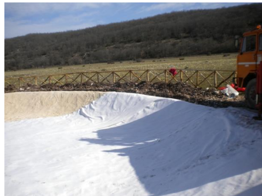
Deposizione teli impermeabilizzanti (2)
