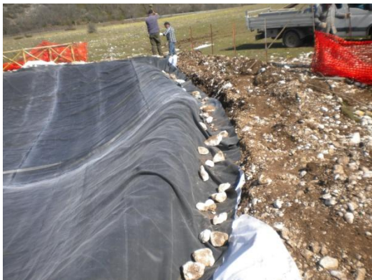
Deposizione teli impermeabilizzanti (3)
