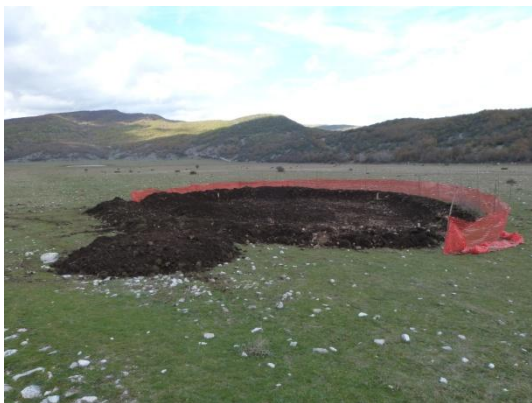
Scavo e sagomatura stagno (1)
